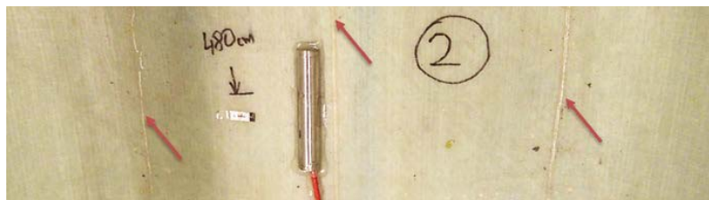
Rys. 8. Prowadzenie włókien światłowodowych na dolnej części powłoki dźwigara (od strony wewnętrznej)
