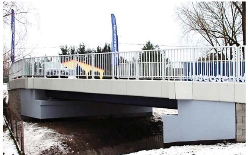
Rys. 3. Widok mostu kompozytowego
